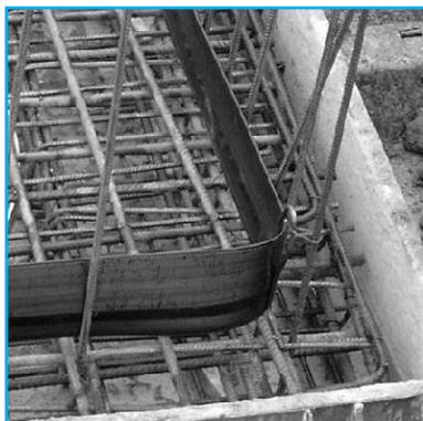
X Il nastro di segnalazione largo 2,5 cm circa è sistemato ad un'altezza compresa tra 2,5 e 5,0 cm circa e serve per determinare e controllare la profondità di posa. La profondità massima d'infissione della base del profilo con la gomma espansiva è di 5,0 cm.
